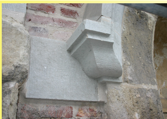
Bateig Azul gebruikt ter vervanging van de Balegemse steen bij de restauratie van de Emile Braunschouw (foto Monument Vandekerckhove).
