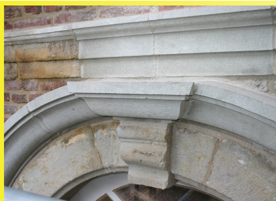
Bateig Azul gebruikt ter vervanging van de Balegemse steen bij de restauratie van de Emile Braunschouw (foto Monument Vandekerckhove).
